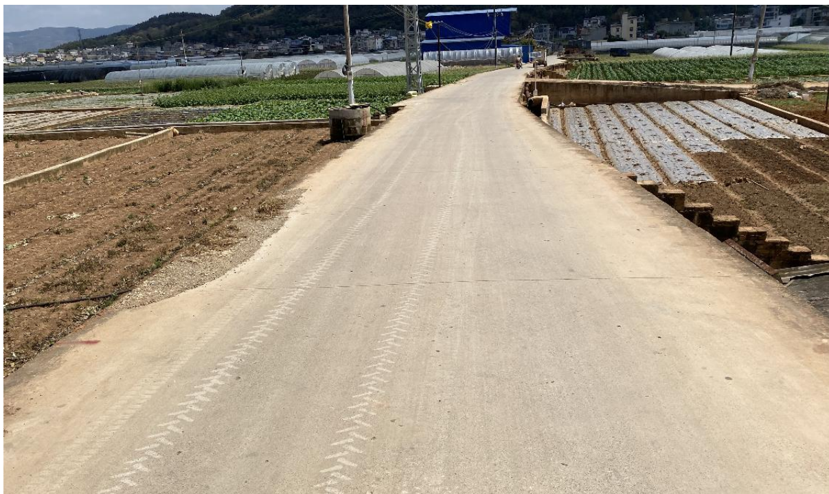
照片 4-36 施工条带穿过现状设施现状
