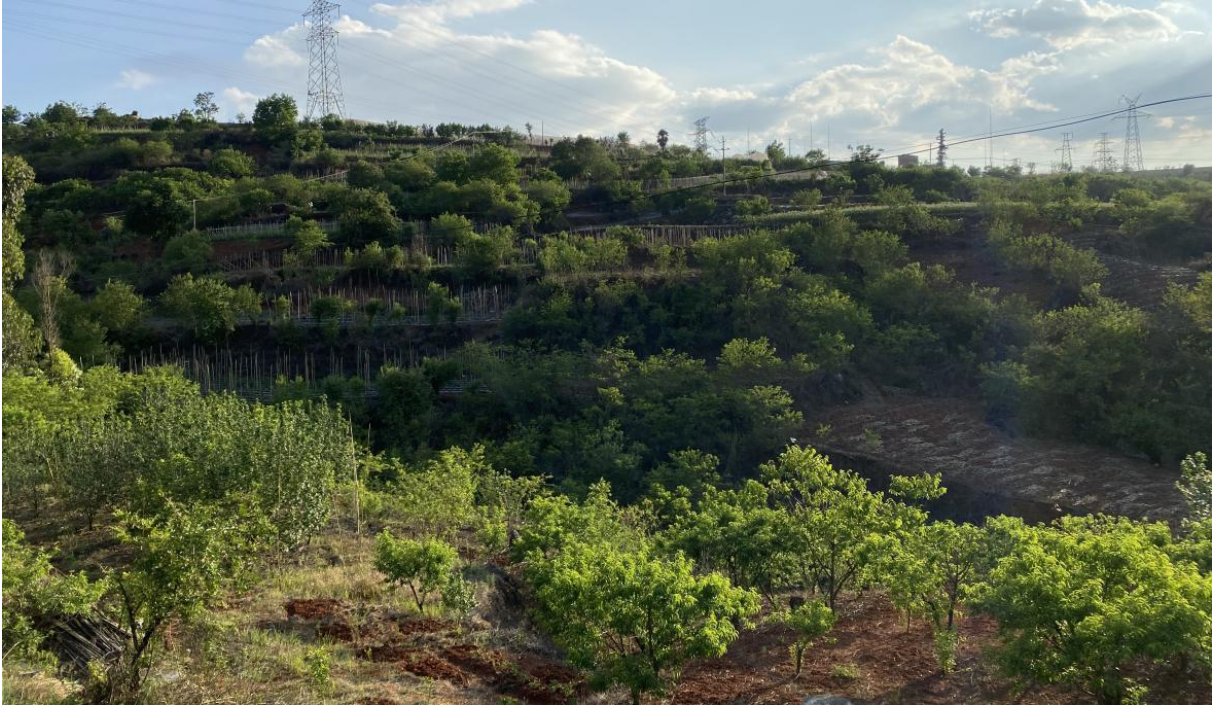
照片 4-5 弃渣场现状
