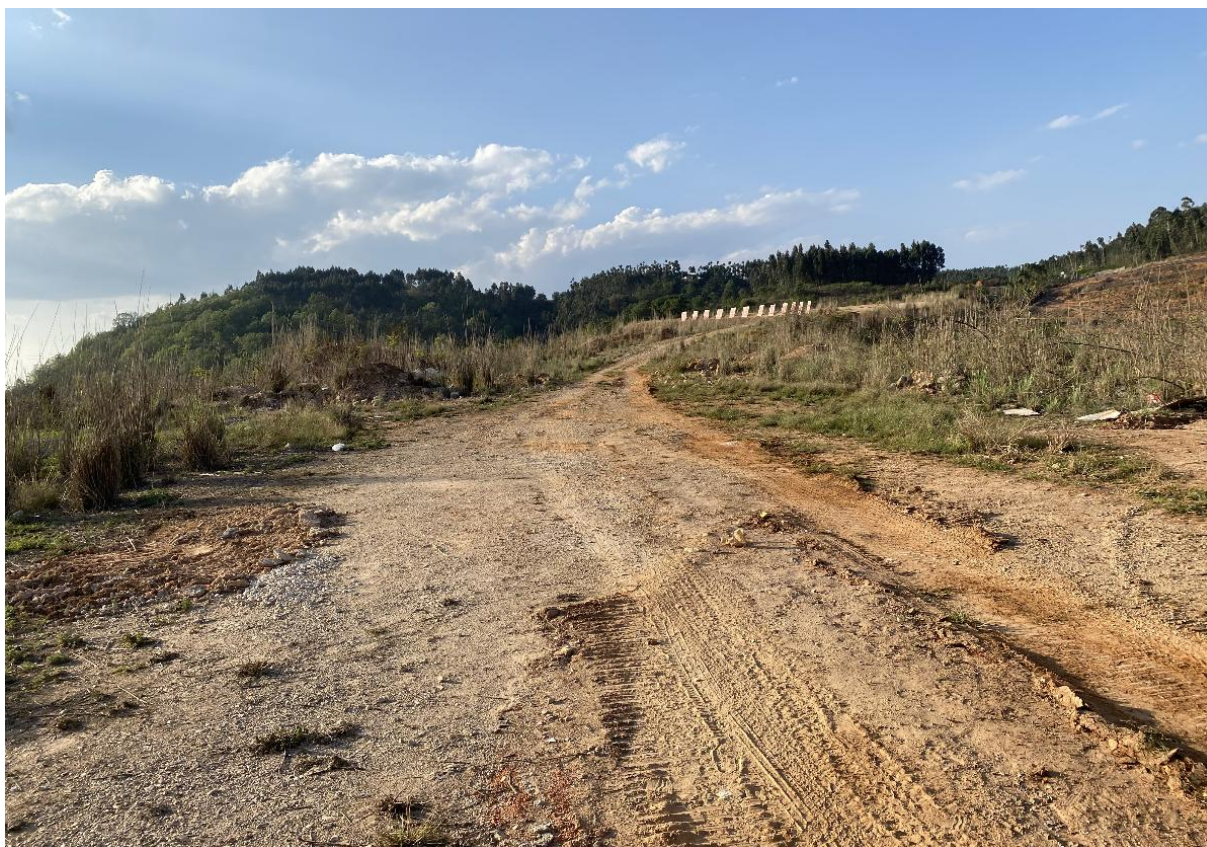
照片 4-7 里山泵站提水管阀室进场道路现状
