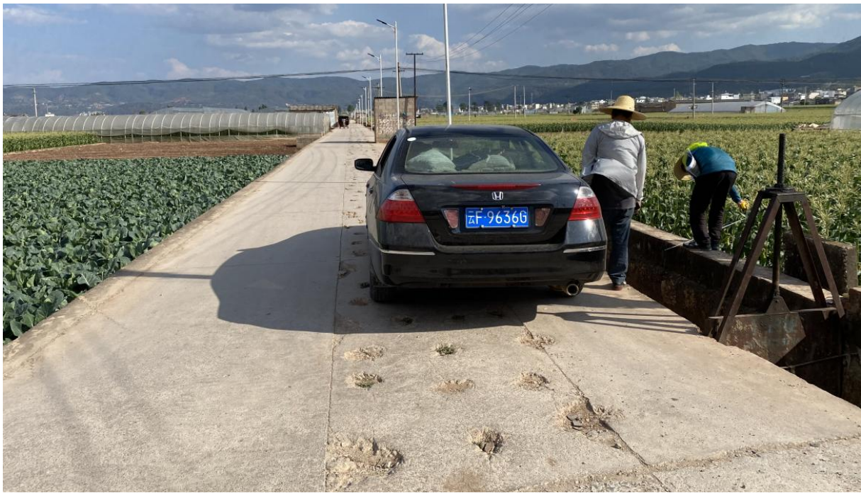
照片 4-46 施工条带穿过现状设施现状
