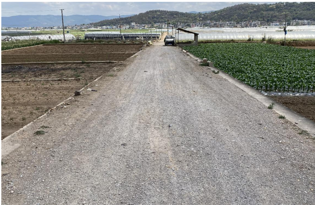
照片 4-34 施工条带穿过现状设施现状
