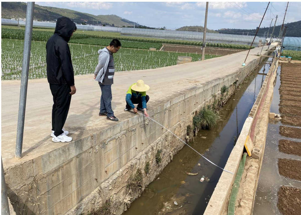
照片 4-44 施工条带穿过现状设施现状
