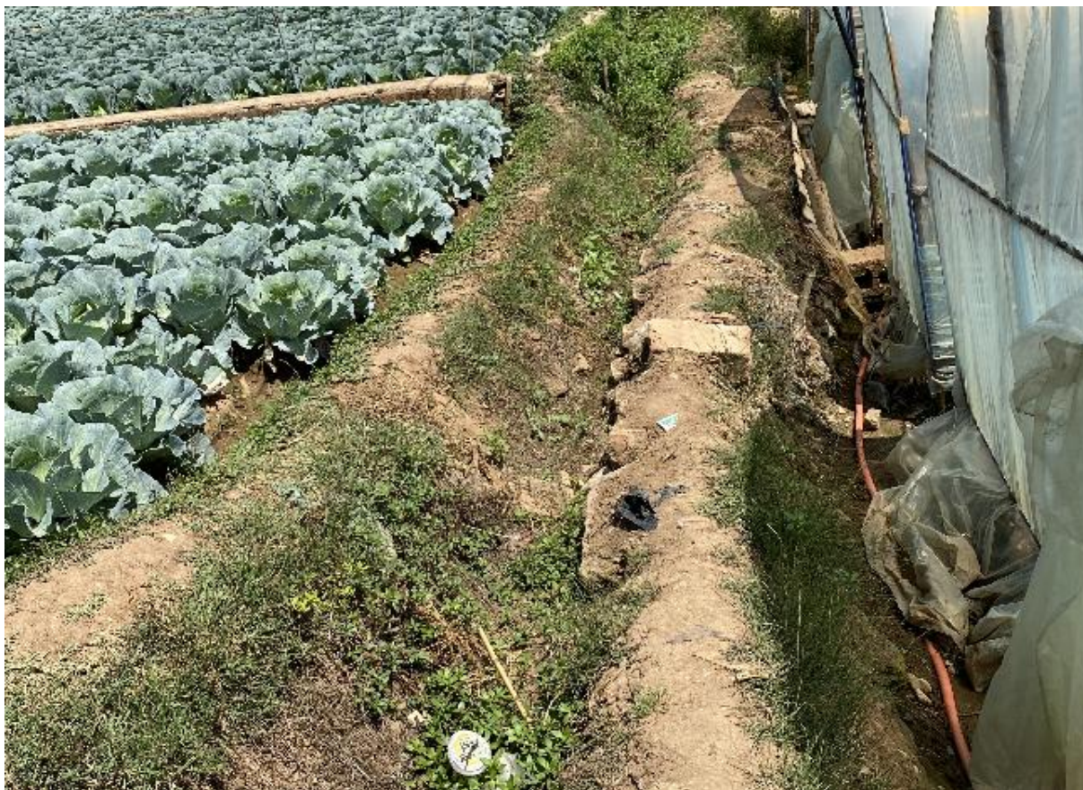
照片 4-24 施工条带穿过现状设施现状
