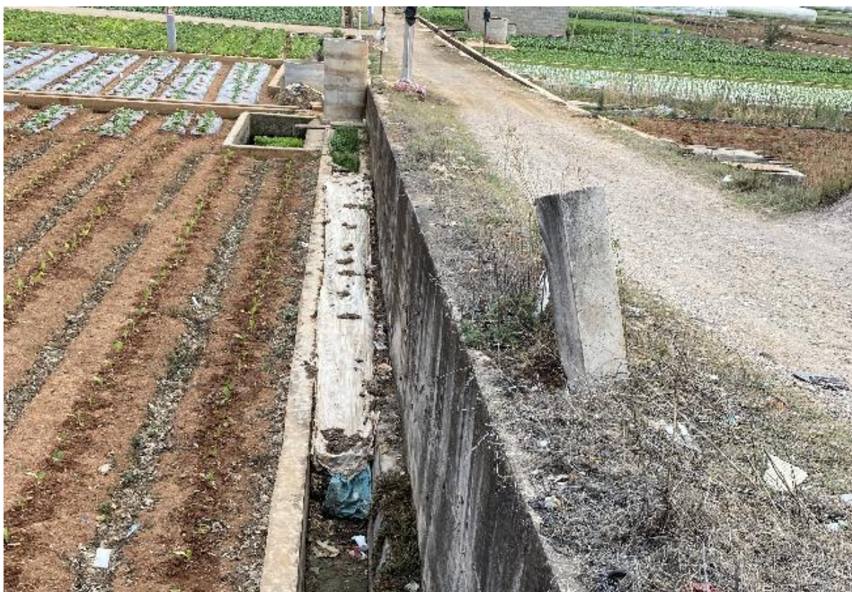
照片 4-37 施工条带穿过现状设施现状
