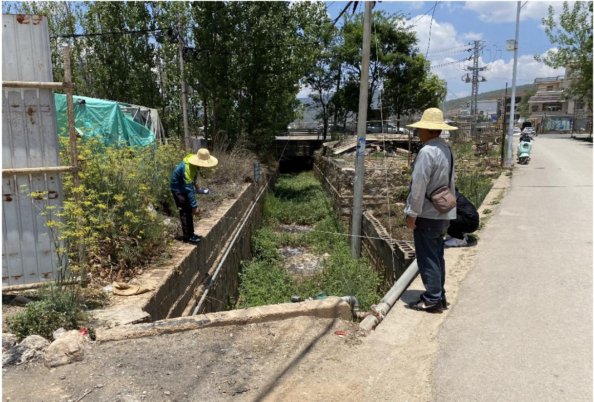
照片 4-32 施工条带穿过者弯大河现状
