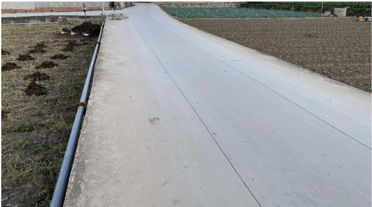
照片 4-47 施工条带穿过现状设施现状
