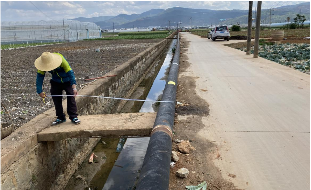
照片 4-41 施工条带穿过现状设施现状
