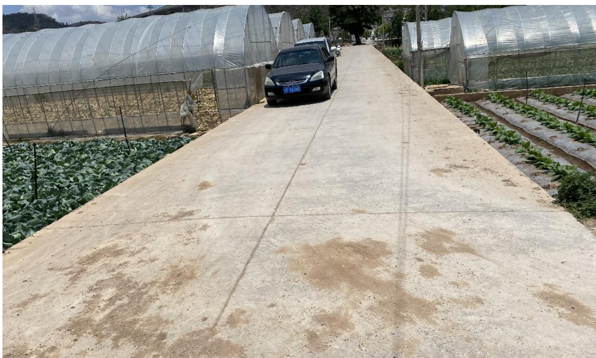
照片 4-31 施工条带穿过现状设施现状
