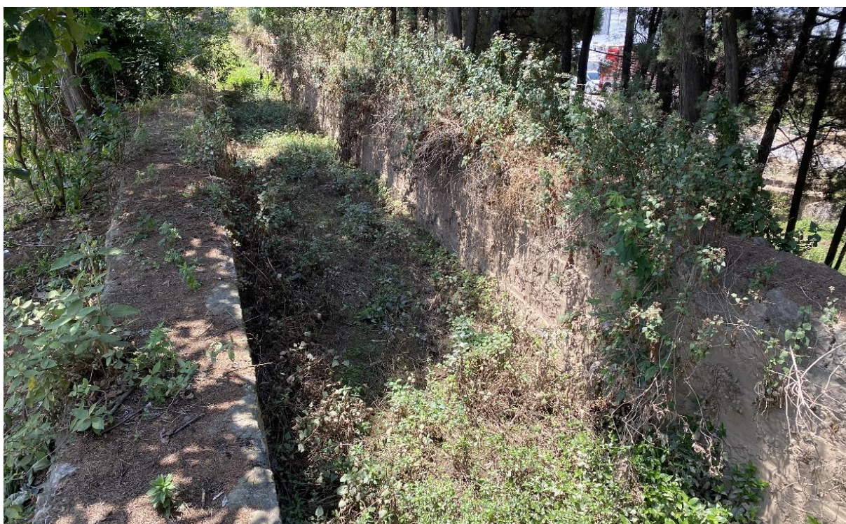
照片 4-25 施工条带穿过二级站沟现状
