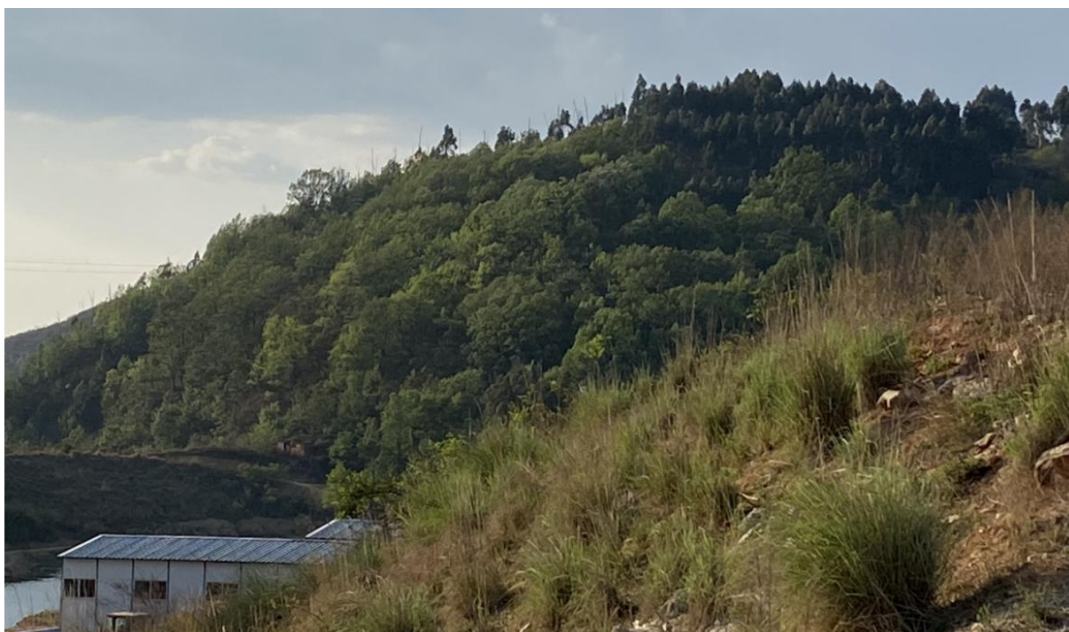
照片 4-9 里山泵站提水管施工条带现状
