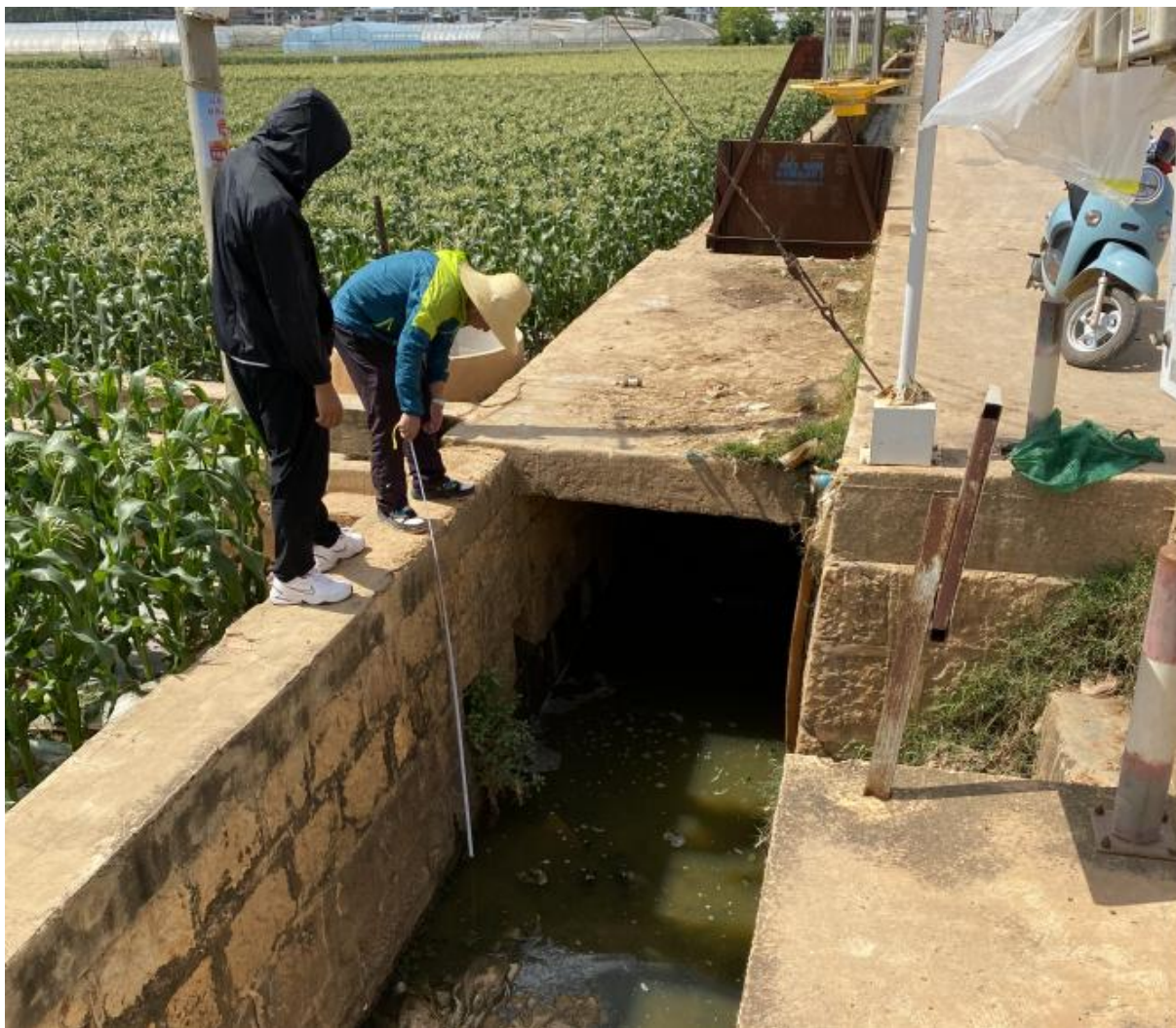
照片 4-42 施工条带穿过现状设施现状
