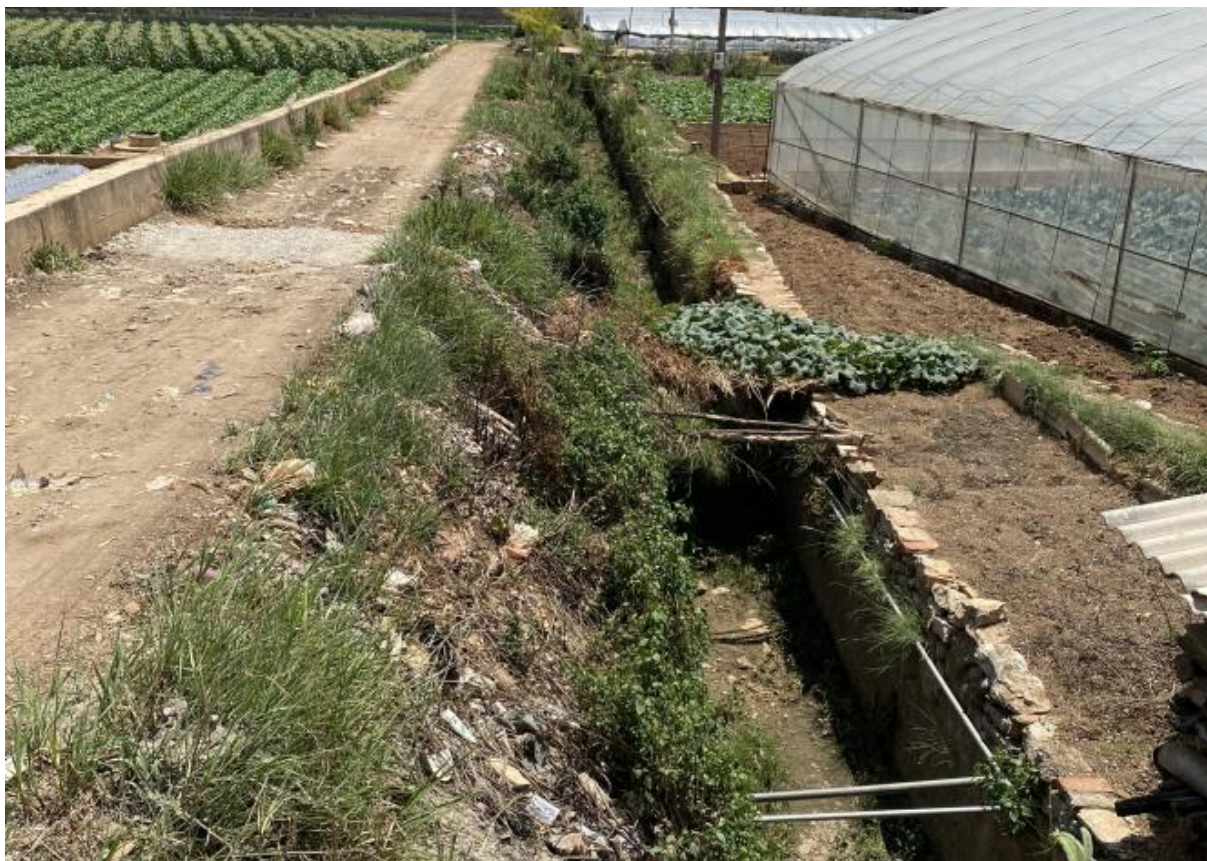
照片 4-28 施工条带穿过现状设施现状
