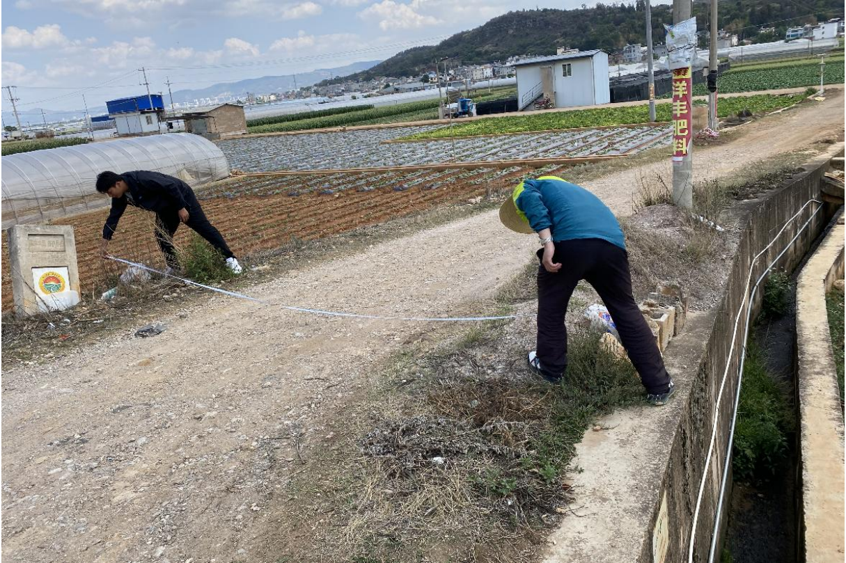
照片 4-38 施工条带穿过现状设施现状
