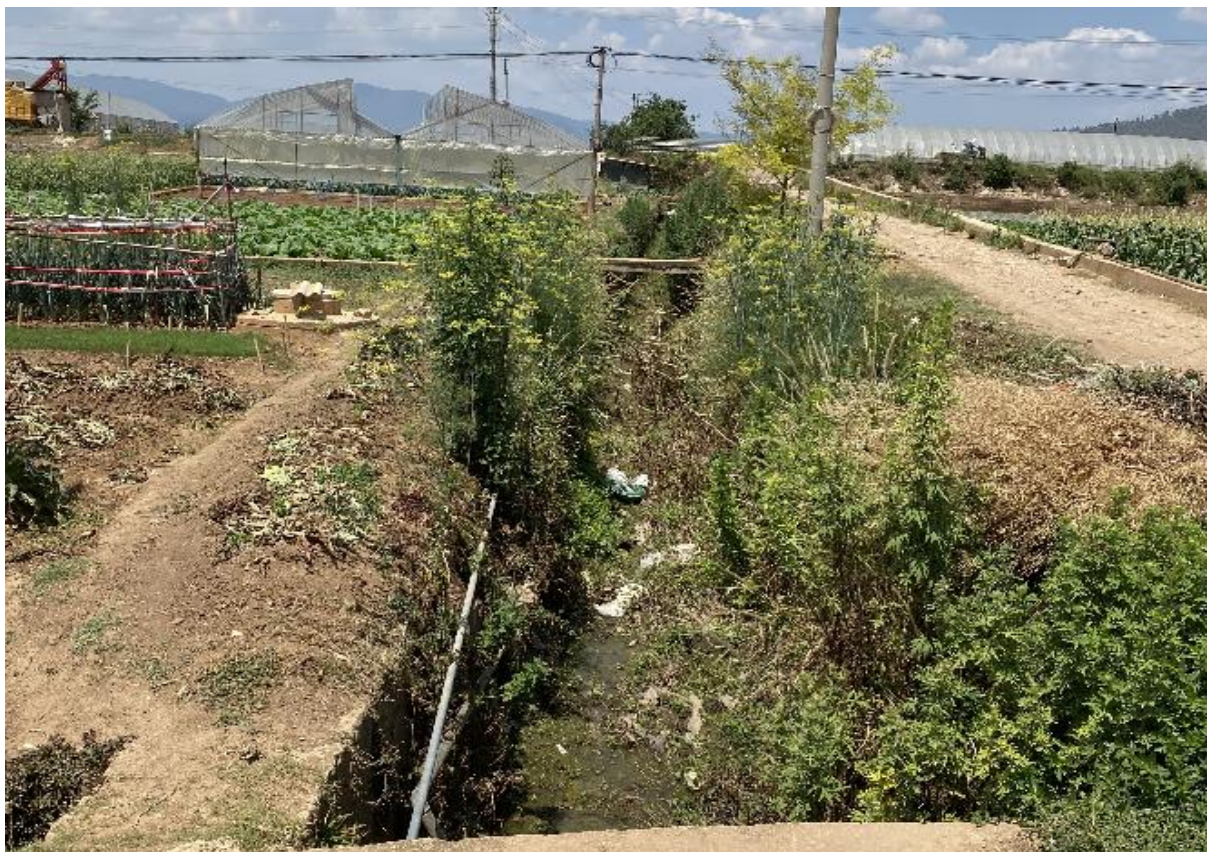
照片 4-26 施工条带穿过沙沟嘴灌渠现状
