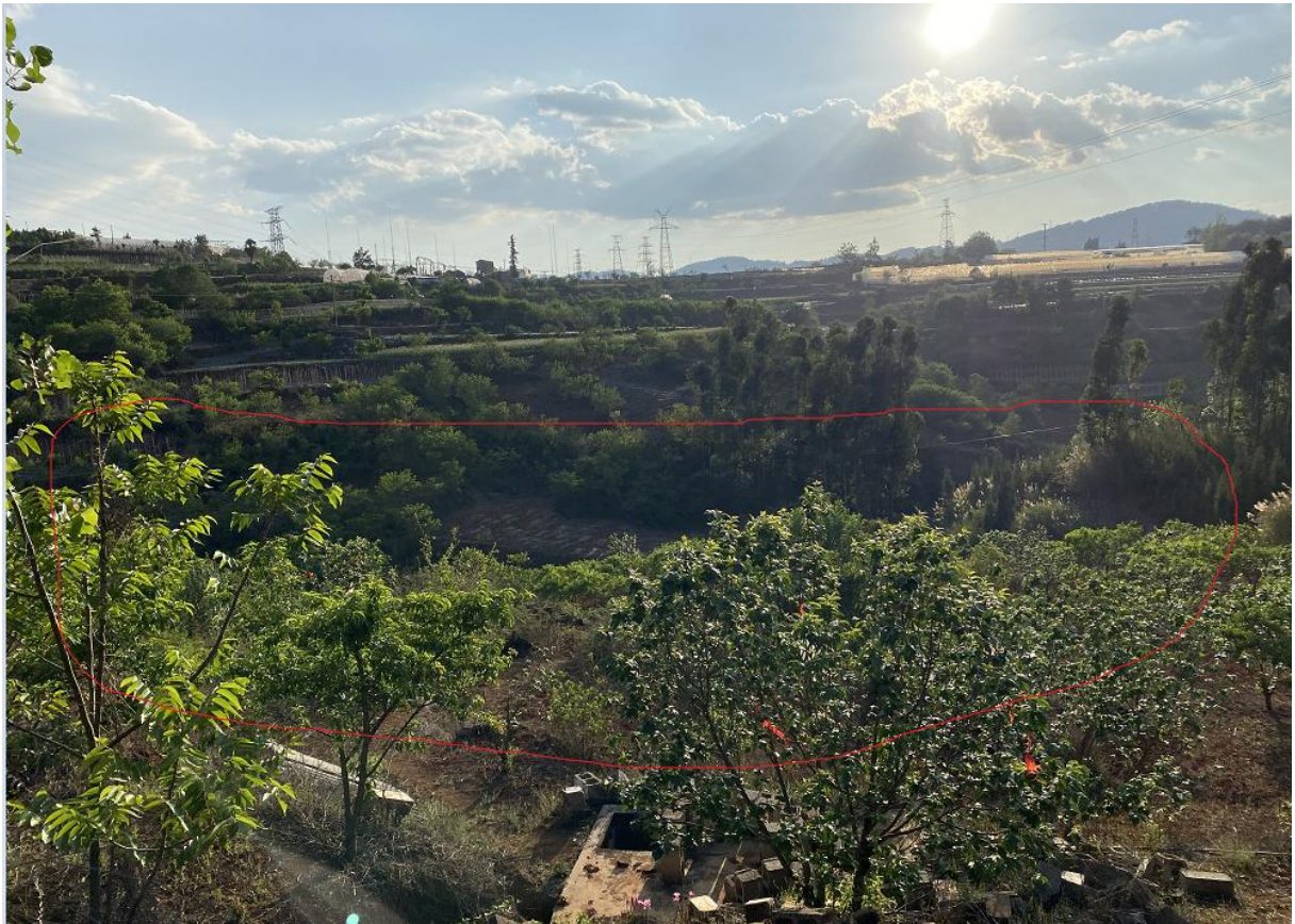
照片 4-4 弃渣场现状
