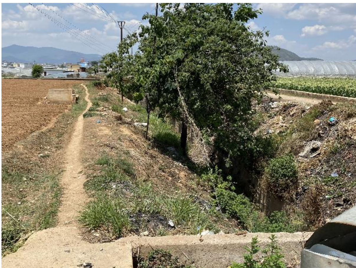
照片 4-27 施工条带穿过沙沟嘴灌渠现状
