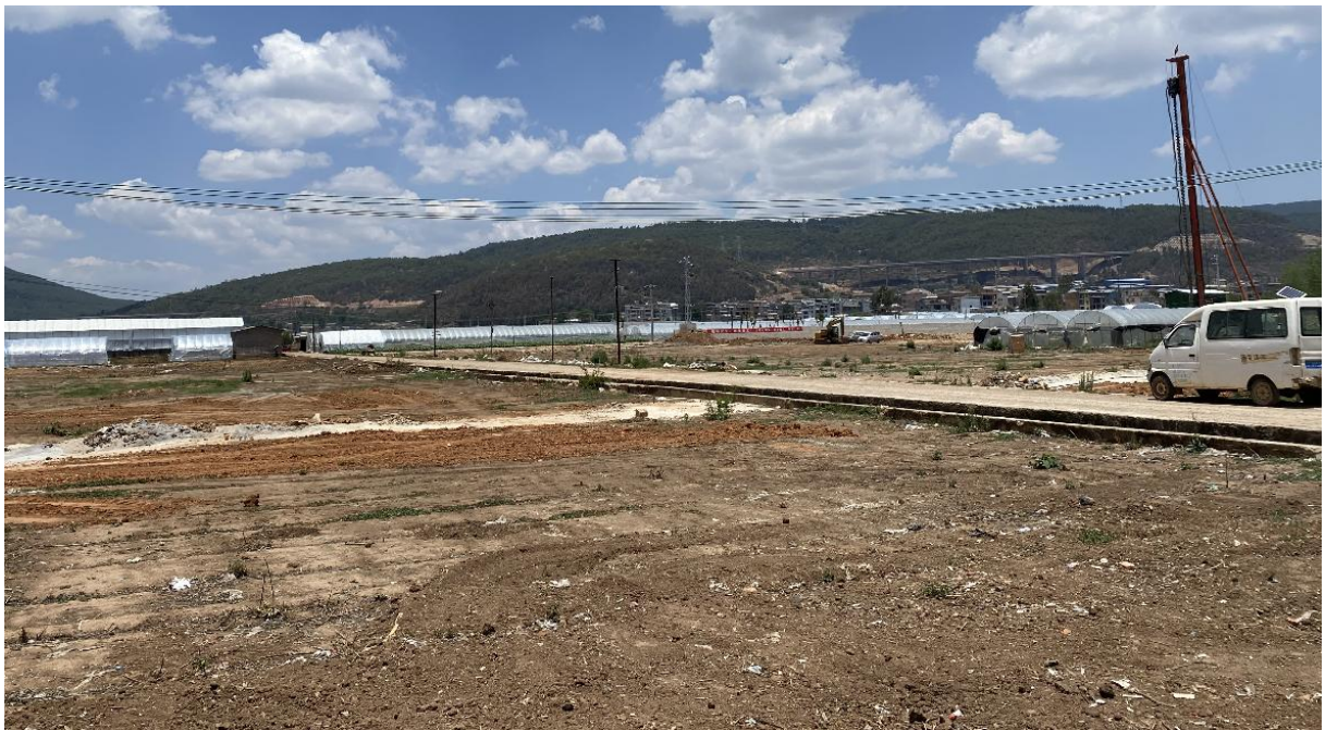
照片 4-33 施工条带穿过现状设施现状
