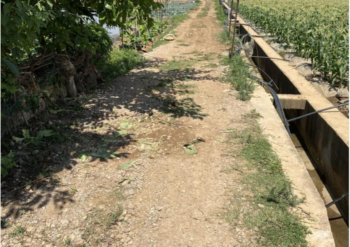
照片 4-22 施工条带穿过现状设施现状
