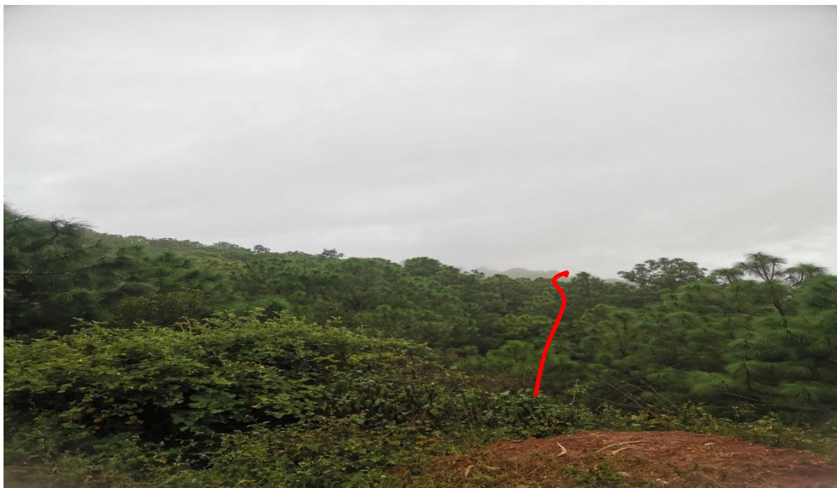
照片 4.1-48 地块四十二、四十三施工便道现状地貌
