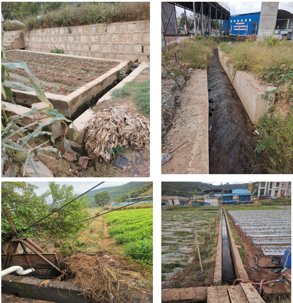
图 4.7-1 部分地块水田周边沟渠现状照片
