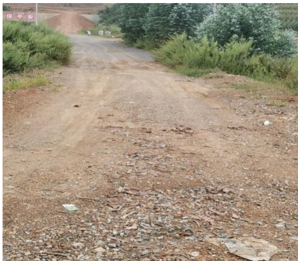
照片 4.1-17 地块三施工便道现状地貌
