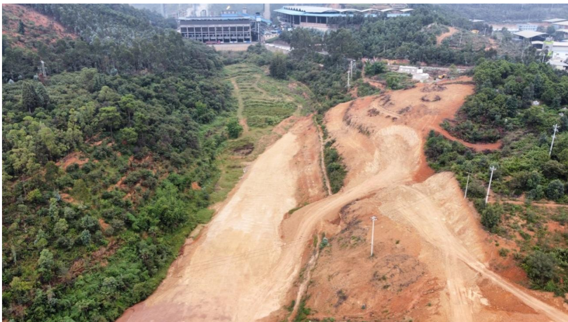
照片 4.1-4 地块六填平区现状地貌
