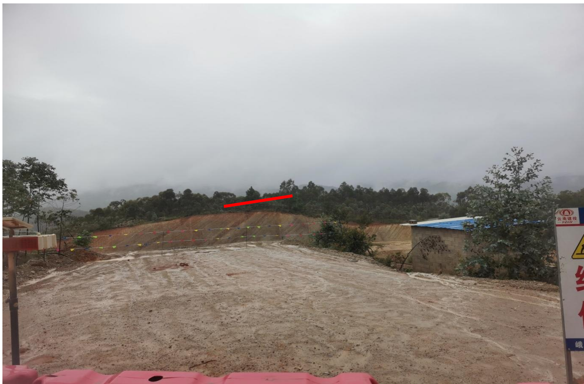
照片 4.1-46 地块三十六、三十七施工便道现状地貌
