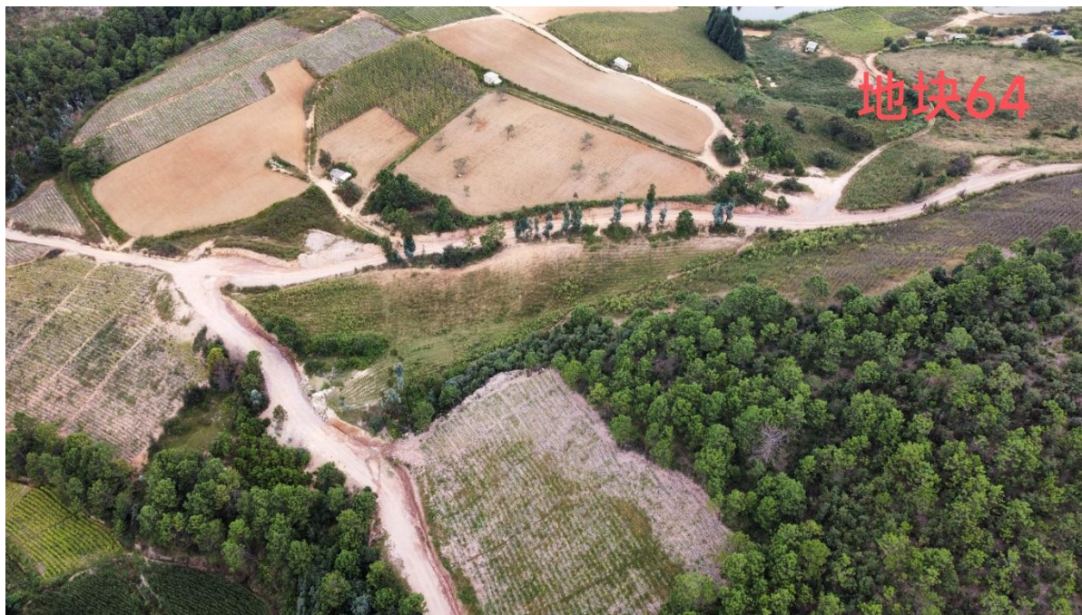
照片 4.1-35 地块六十四施工便道现状照片
