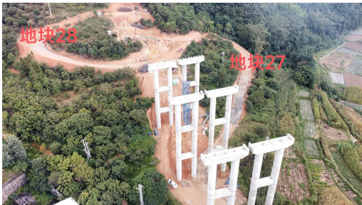
照片 4.1-30 地块二十七、二十八施工便道现状地貌
