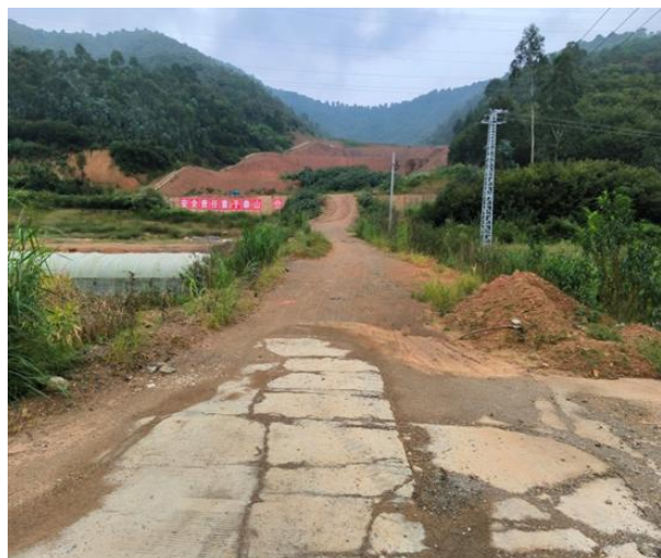
照片 4.1-16 地块二施工便道现状地貌
