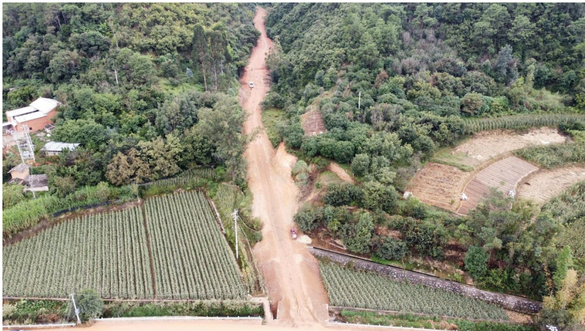
照片 4.1-28 地块二十五施工便道现状地貌
