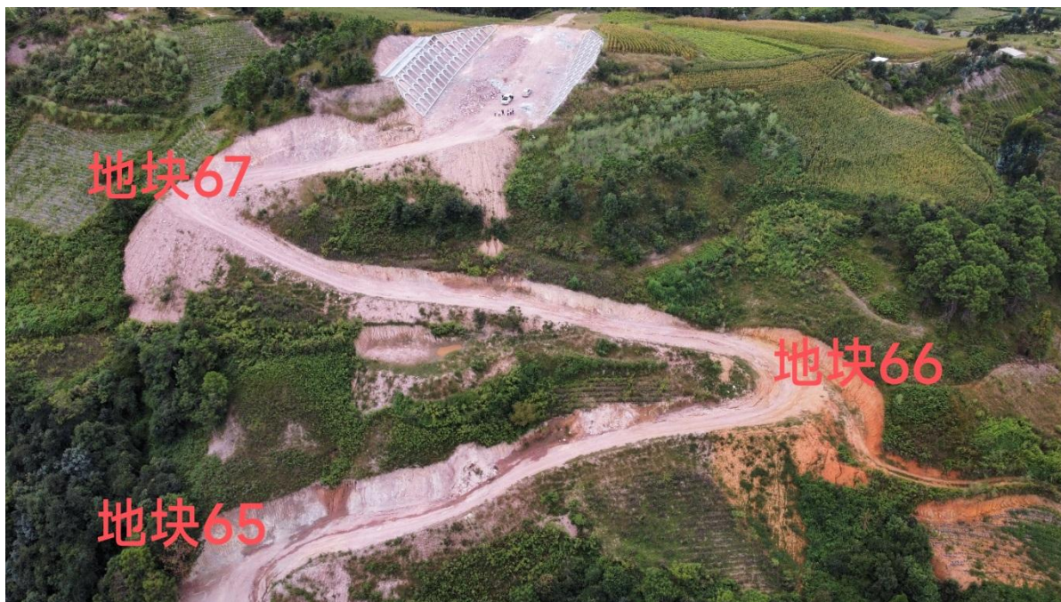
照片 4.1-36 地块六十五、六十六、六十七施工便道现状照片
