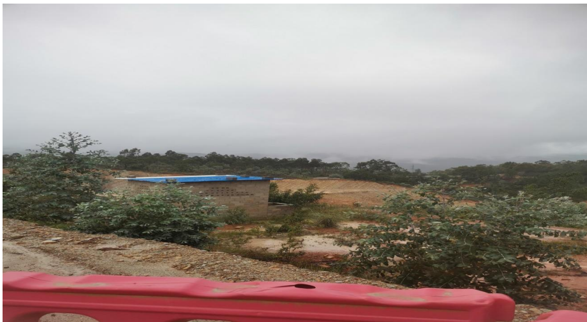
照片 4.1-9 地块三十四配电室现状照片
