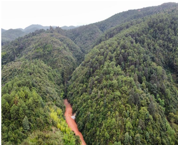
照片 4.1-1 地块 24 弃土场弃土场现状地貌
