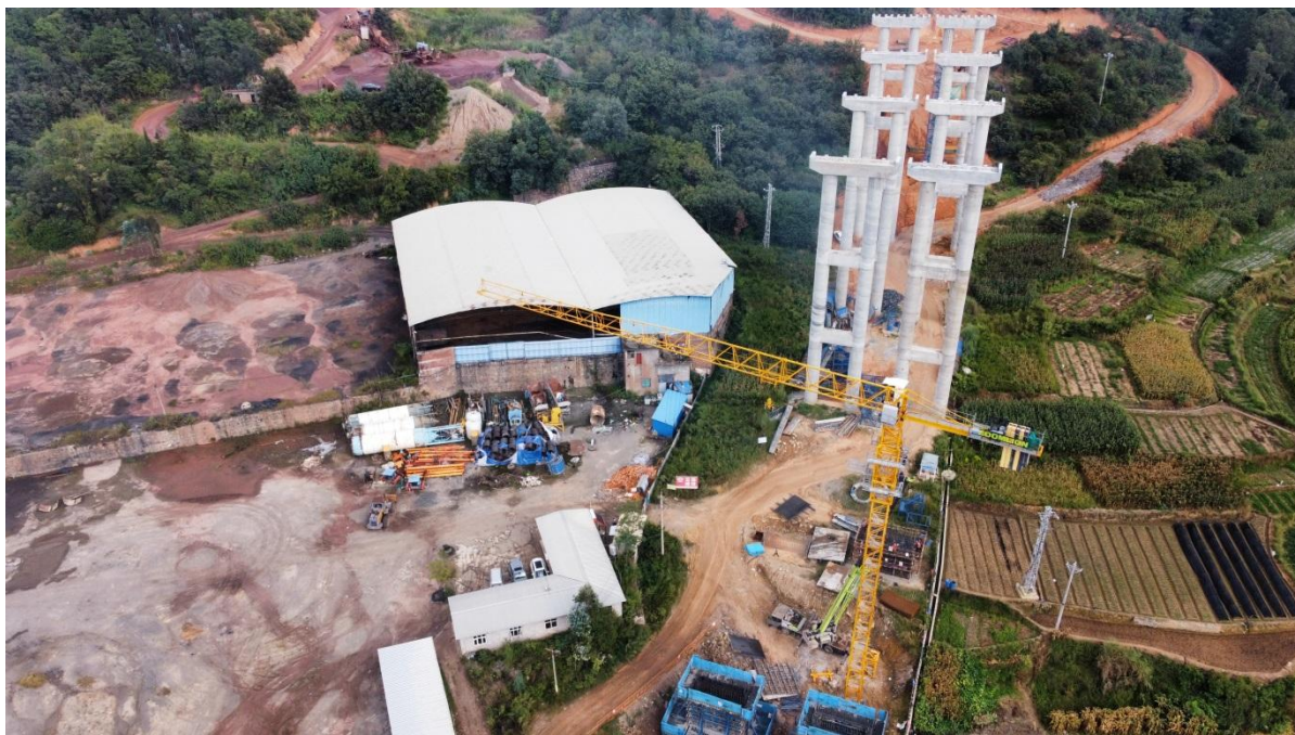
照片 4.1-29 地块二十六施工便道现状地貌
