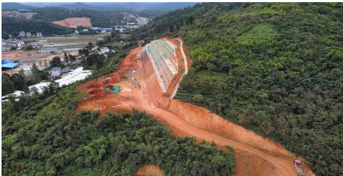
照片 4.1-24 地块十九施工便道现状地貌
