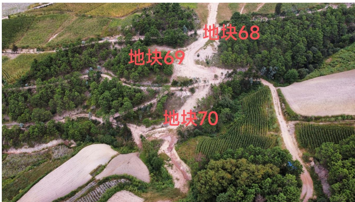
照片 4.1-37 地块六十八、六十九、七十施工便道现状照片
