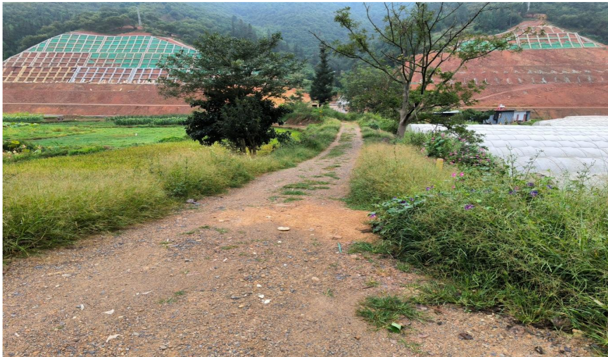
照片 4.1-42 地块四施工便道现状地貌
