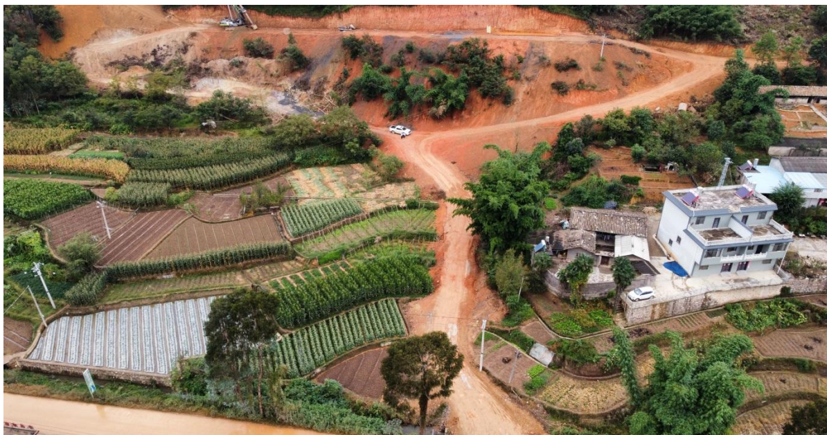
照片 4.1-26 地块二十二施工便道现状地貌
