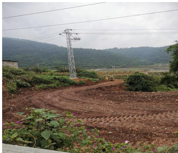
照片 4.1-15 地块一施工便道现状地貌
