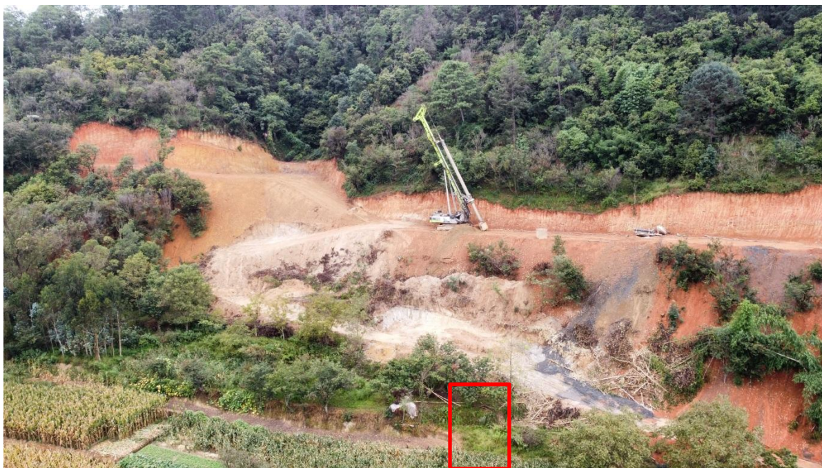
照片 4.1-44 地块二十三施工便道现状地貌
