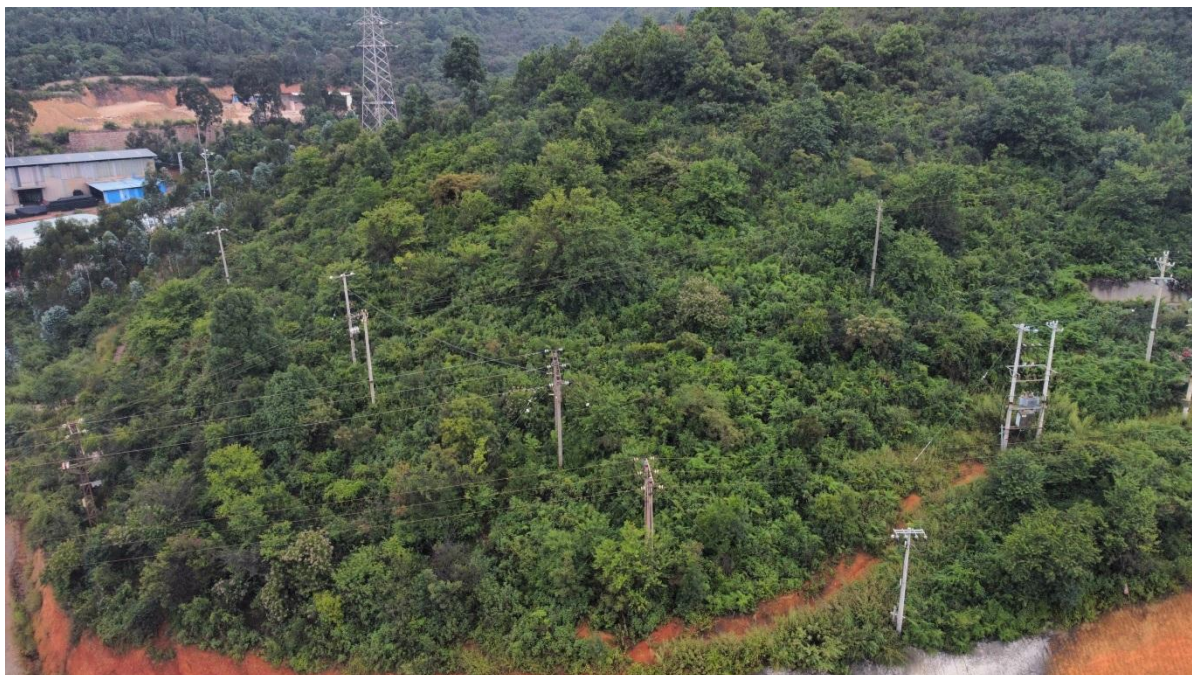
照片 4.1-41 地块八消防水池现状地貌
