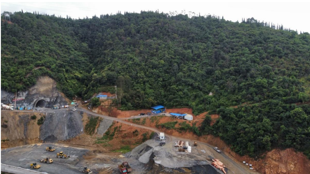
照片 4.1-20 地块九、十施工便道现状地貌
