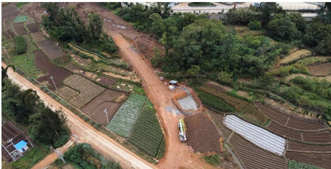
照片 4.1-23 地块十四、十五施工便道现状地貌
