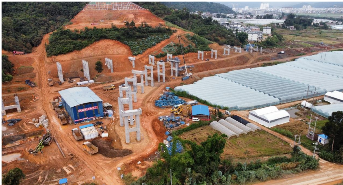
照片 4.1-22 地块十三施工便道现状地貌
