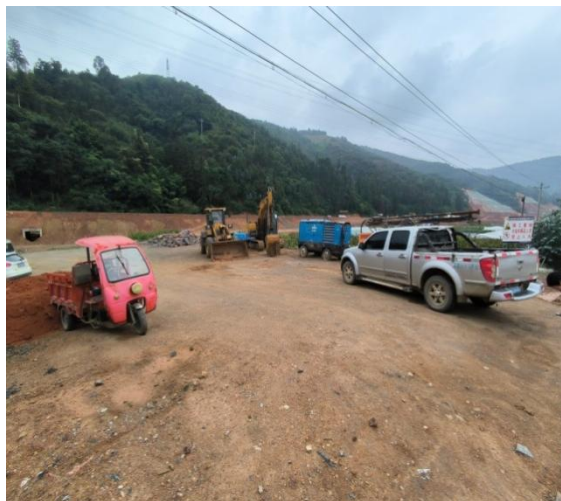
照片 4.1-18 地块五施工便道现状地貌
