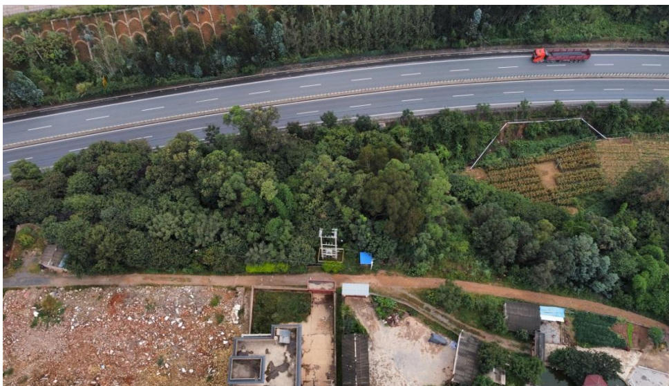
照片 4.1-19 地块七施工便道现状地貌
