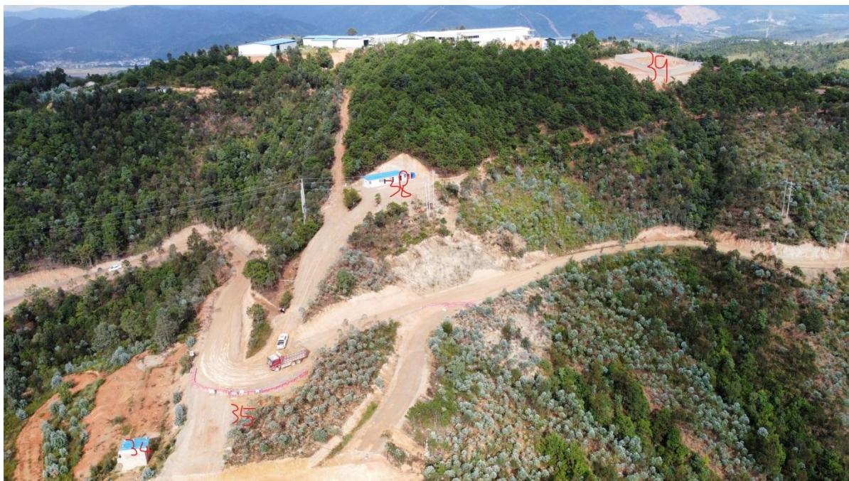
照片 4.1-32 地块三十五施工便道现状地貌
