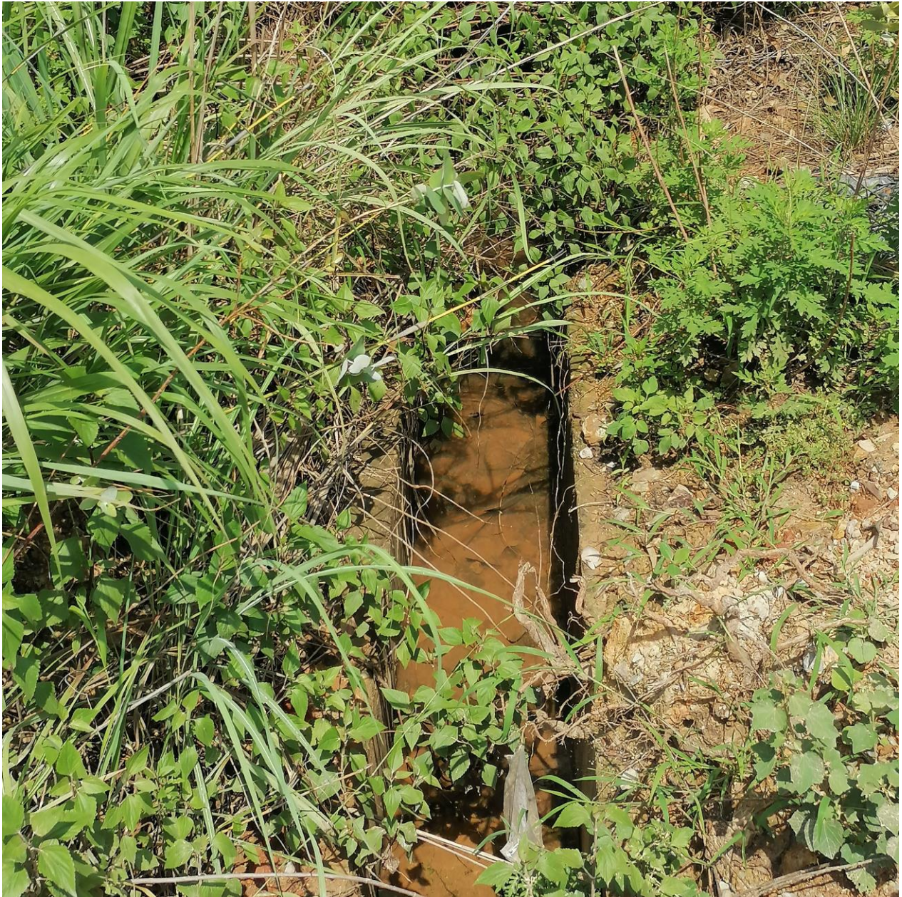
图 4-8 水田灌溉沟渠现状
