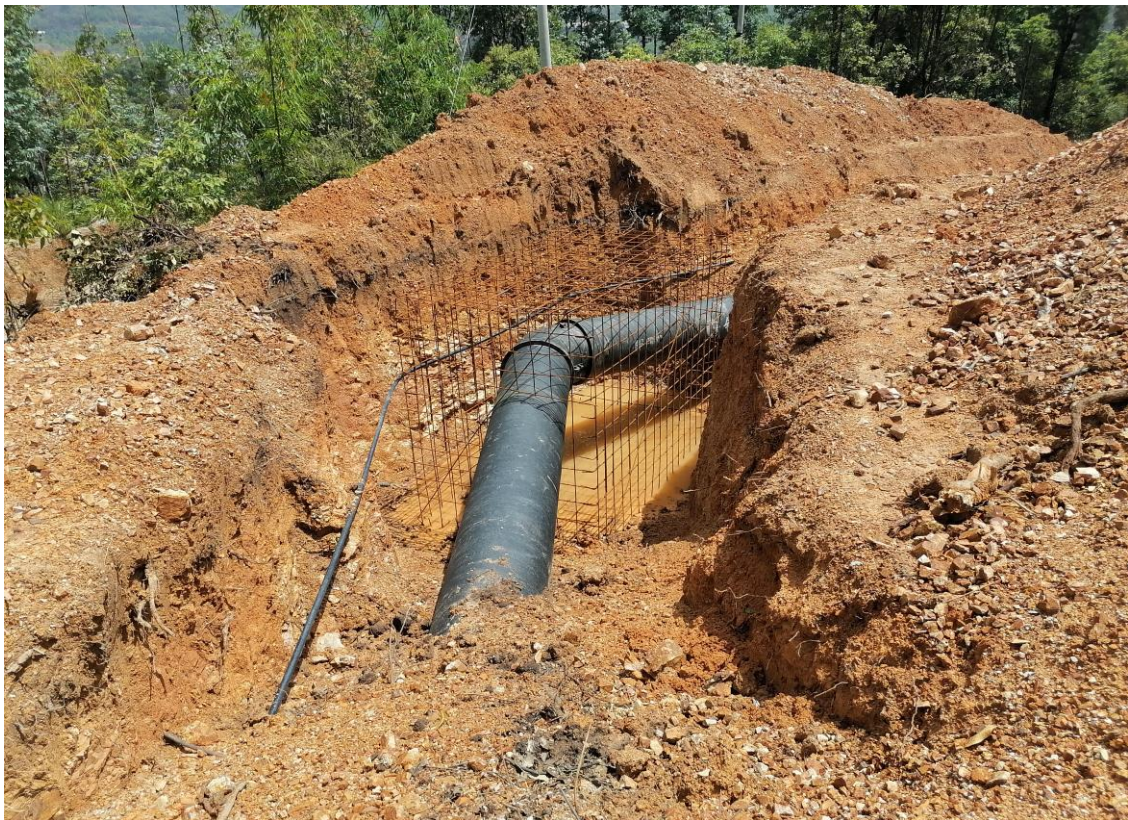
照片 4-6 输水管道埋设
